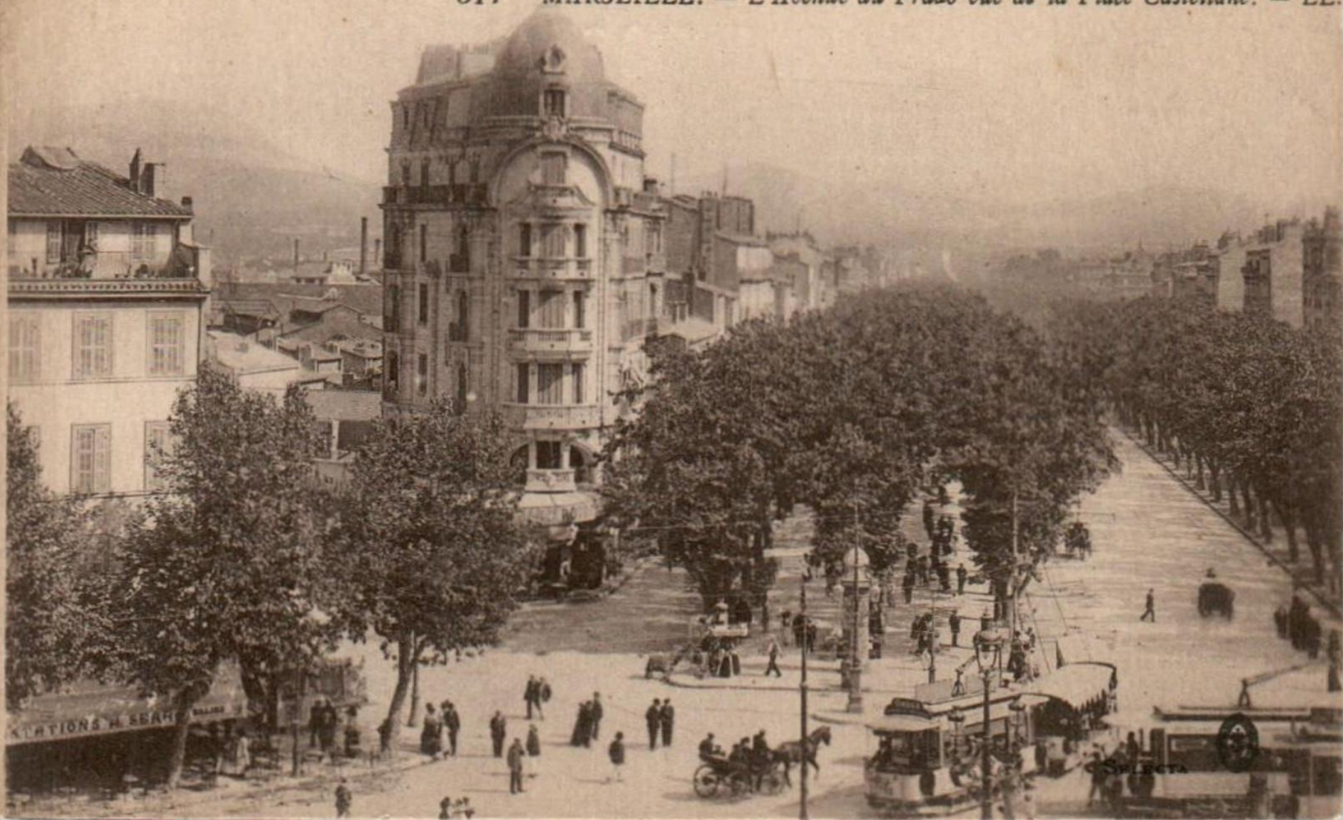
317 MARSEILLE. — L'Avenue du Prado vue de la Place Castellane. — LL.
